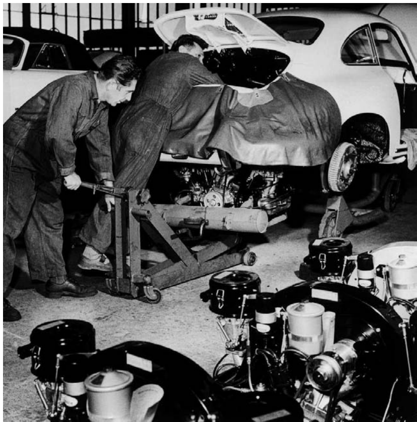
Un coupé 356 A, mill. 1956 et une 356 Speedster, mill. 1955 à Stuttgart, photo de presse de 1956 (en haut). Montage du moteur dans une Porsche 356 B (en bas)
